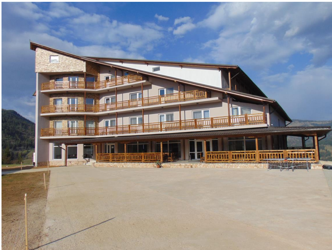
Structură nouă de cazare la Pleșești – Perla Apusenilor cu 45 camere cu finalizare în 2019
